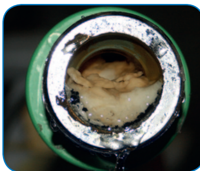
völlig verkalkte Warmwasserleitung,
