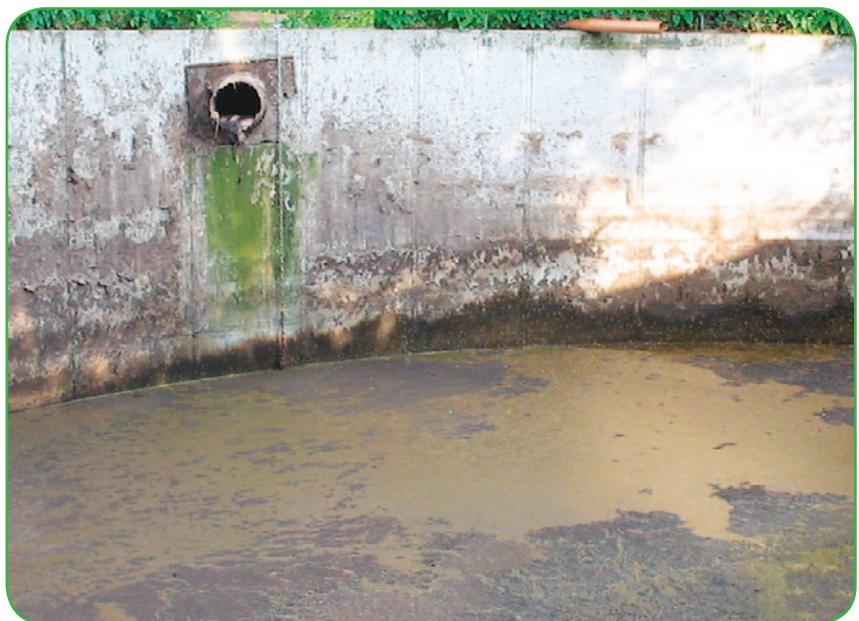
Güllegrube, nicht gerührt, zeigt gänzlichen Abbau der Schwimmschicht für aerobe Güllelagerung
